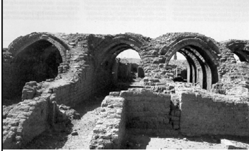
Entrepôts du pharaon Ramsès II, Louxou, XIII e siècle av. J.-C.
