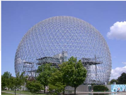
Coupole du bâtiment USA, Expo 1967, Montréal Buckminster Fuller
